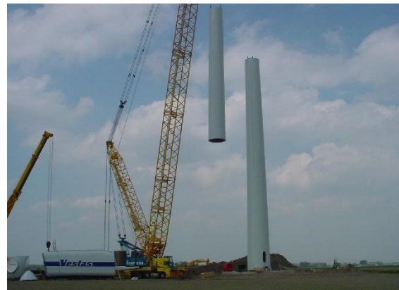
Foto: De bouw van een Vestas V80 windturbine in 2002. Binnen een aantal jaren worden ze vervangen door turbines met meer capaciteit en op hogere ashoogte voor meer rendement...
